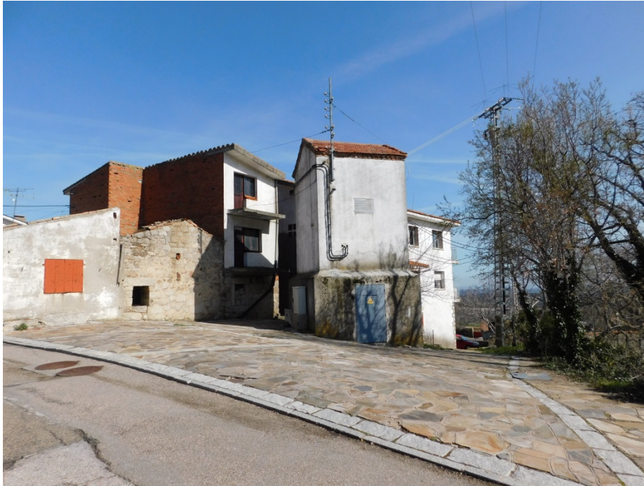
Centro transformador en calle Real
