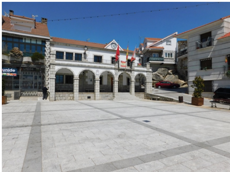
Fachada y soportales del Ayuntamiento
