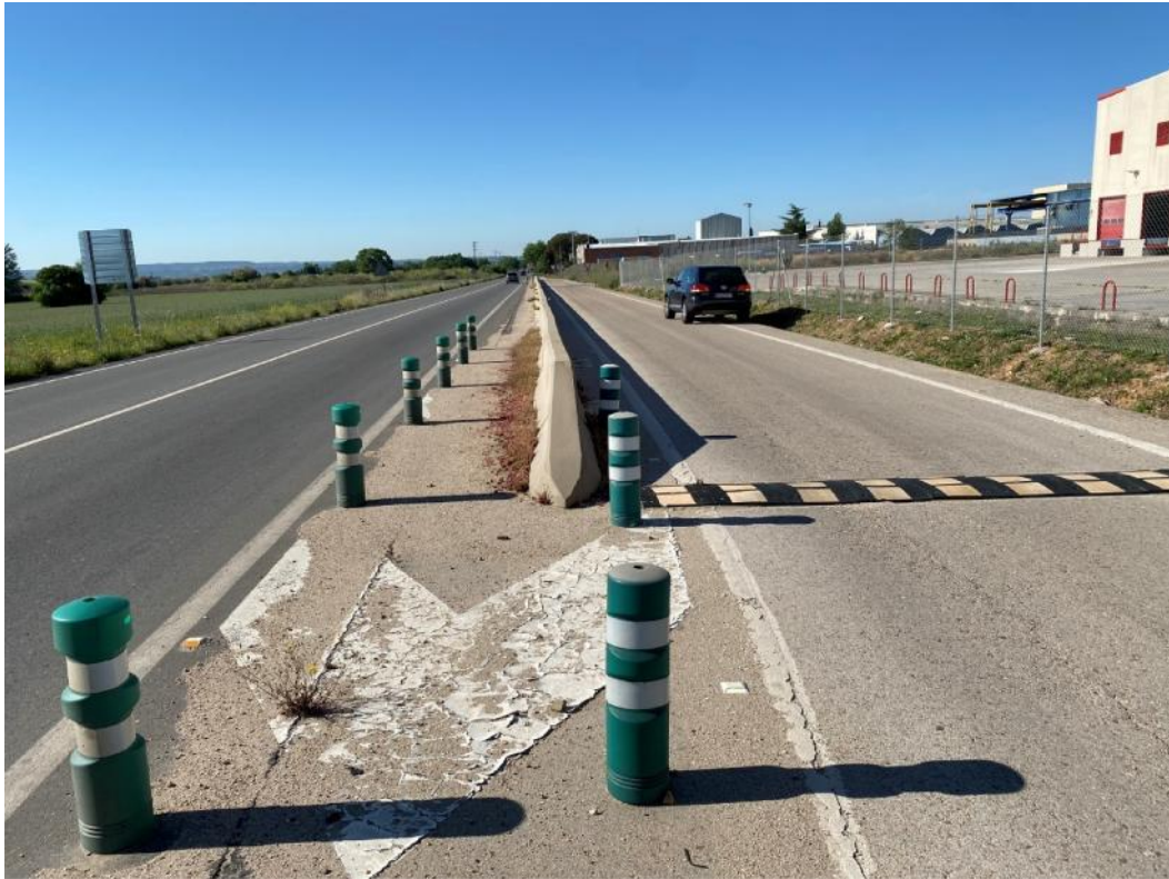
Tramo de vía de servicio existente para acceso a la UE-22
