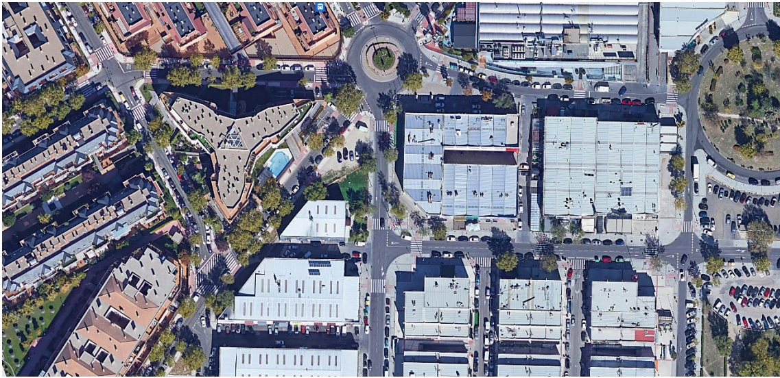
Fig.7 Estado actual de la zona.
