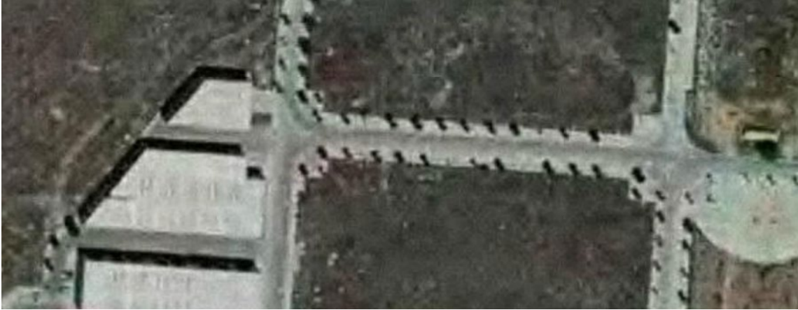
Fig.6 Imagen de la zona sólo con las naves ejecutadas
