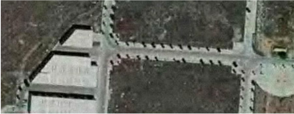
Fig.18 Imagen de la zona sólo con las naves ejecutadas
