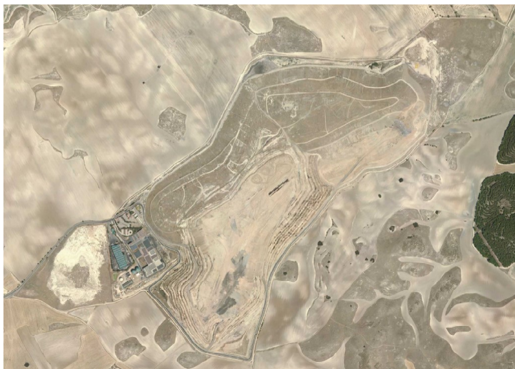
Figura Situación actual del vertedero (Imagen PNOA 2017)
