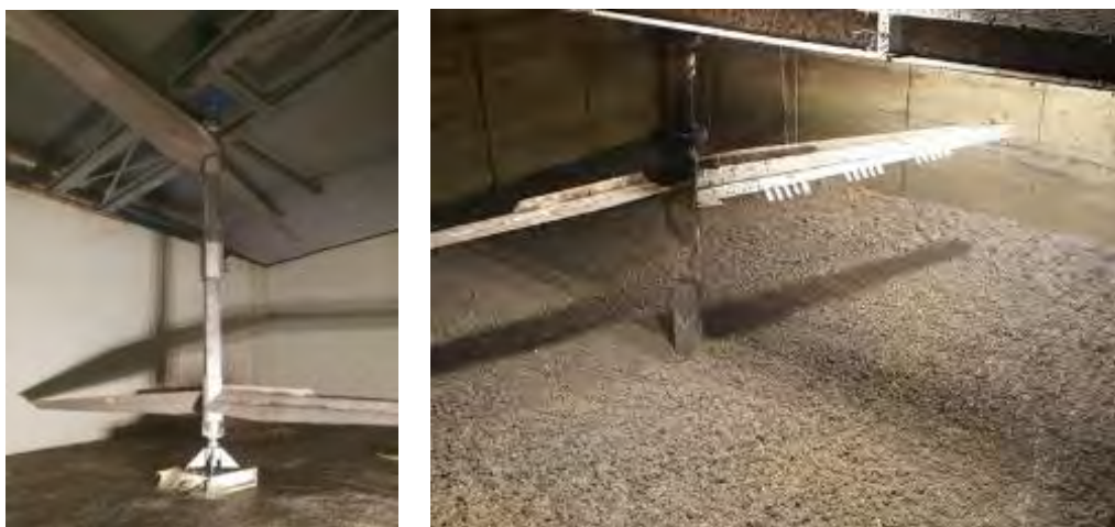
Tanque de premezcla previo al digestor anaerobio
