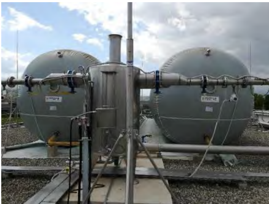
Gasómetros ubicados en la cubierta del digestor anaerobio para almacén temporal de biogás
