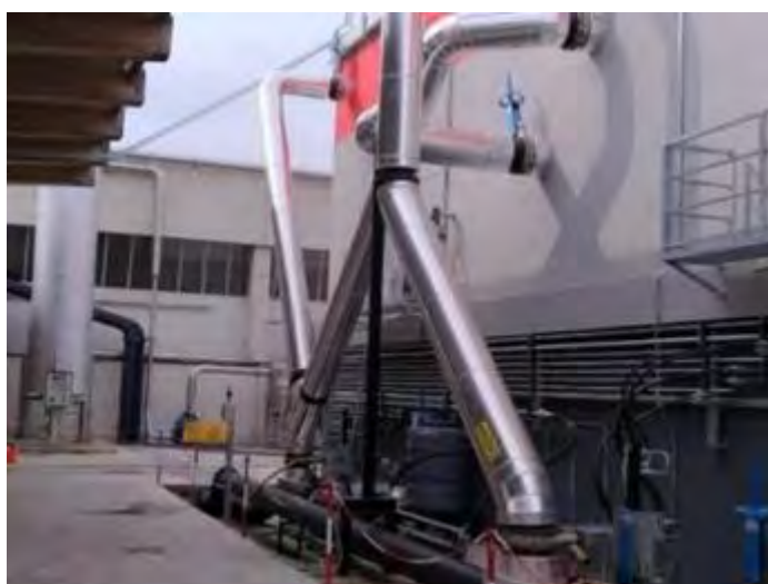
Bomba de descarga (izq.) y central hidráulica (der).
