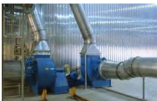
Ventiladores y fondo del sistema de aspiración forzada
