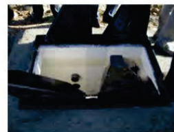
10. Colocación de marco y tapa sobre arqueta modelo A2 "Doble"
