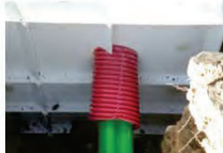
6. Detalle de tubo corrugado, para evitar entrada de hormigón
