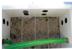
5. Detalle de arqueta taladrada con tubos varios
