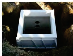
1. Arqueta en zanja
