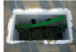
8. Interior de arqueta después de su hormigonado
