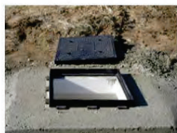
9. Colocación de marco y tapa sobre arqueta modelo A1 "Simple"
