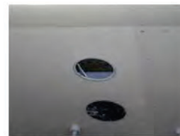
4. Detalle de taladro con broca-corona
