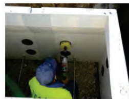
3. Operario taladrando la arqueta con broca tipo corona
