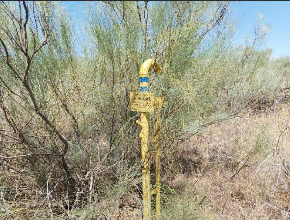
Vista hito gasoducto ENAGAS. La canalización termina en la arqueta SETA que se instalará sobre este gasoducto.
