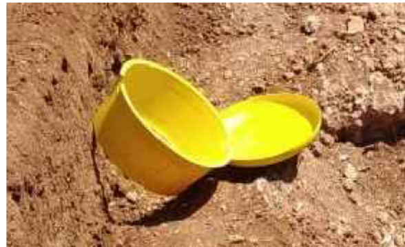
FOTOGRAFIA ARQUETA TIPO "SETA" ANTES DE SU INSTALACIÓN. LA ARQUETA ES DE PEAD Y POR SU PARTE INFERIOR ESTÁ ABIERTA. UNA VEZ INSTALADA LA ARQUETA QUEDA ENTERRADA
