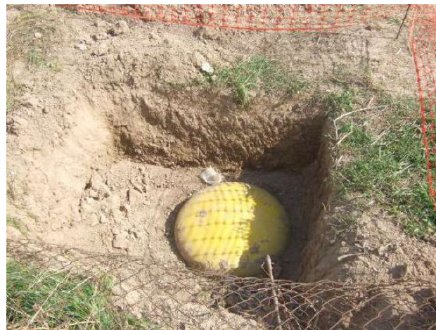
Vista arqueta tipo SETA instalada, antes de ser enterrada.
