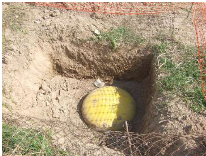
Vista arqueta tipo SETA instalada.
