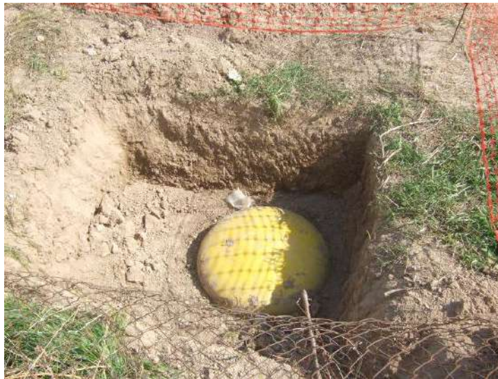
Vista arqueta tipo SETA antes de ser enterrada.
