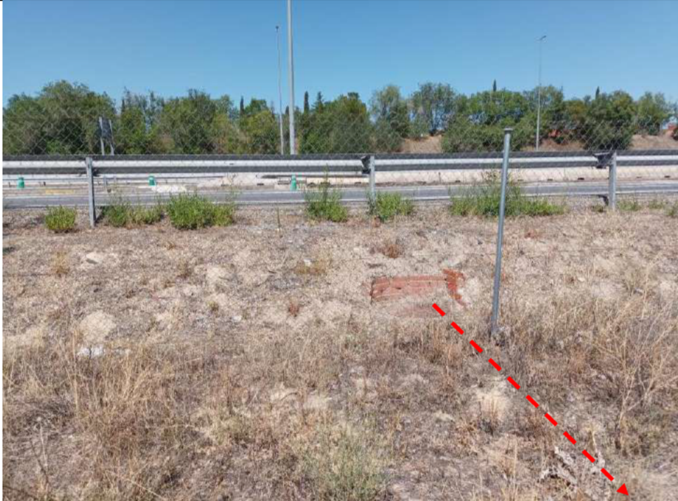
Vista arqueta Telefónica al pie de talud de la vía de servicio de la A1, pagada al vallado exterior. La canalización ira perpendicular al vallado hasta la cámara. Al ser la cámara de mayor tamaño que la tapa, es posible no sea necesario hacer ningún trabajo entre el vallado y la tapa.
