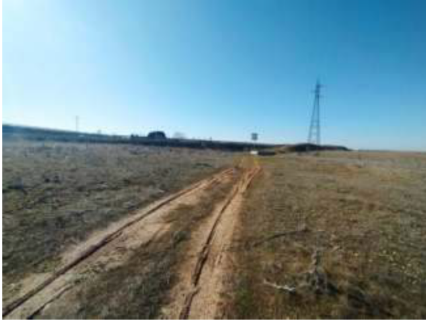
Vista recorrido de canalización desde la arqueta seta hacia la carretera R-2
