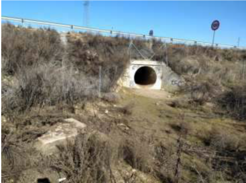
Vista arqueta Telefónica tras el cruce de la R-2
