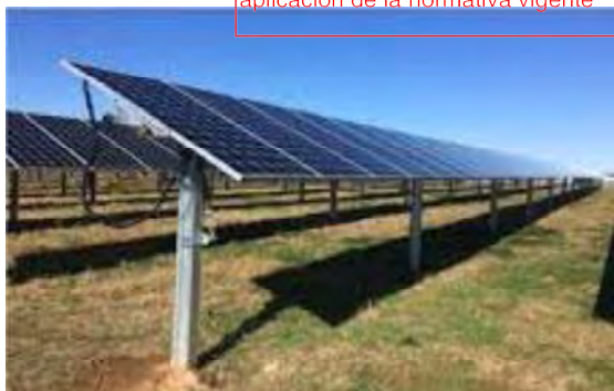
Imagen 3. Estructura giratoria a un eje
