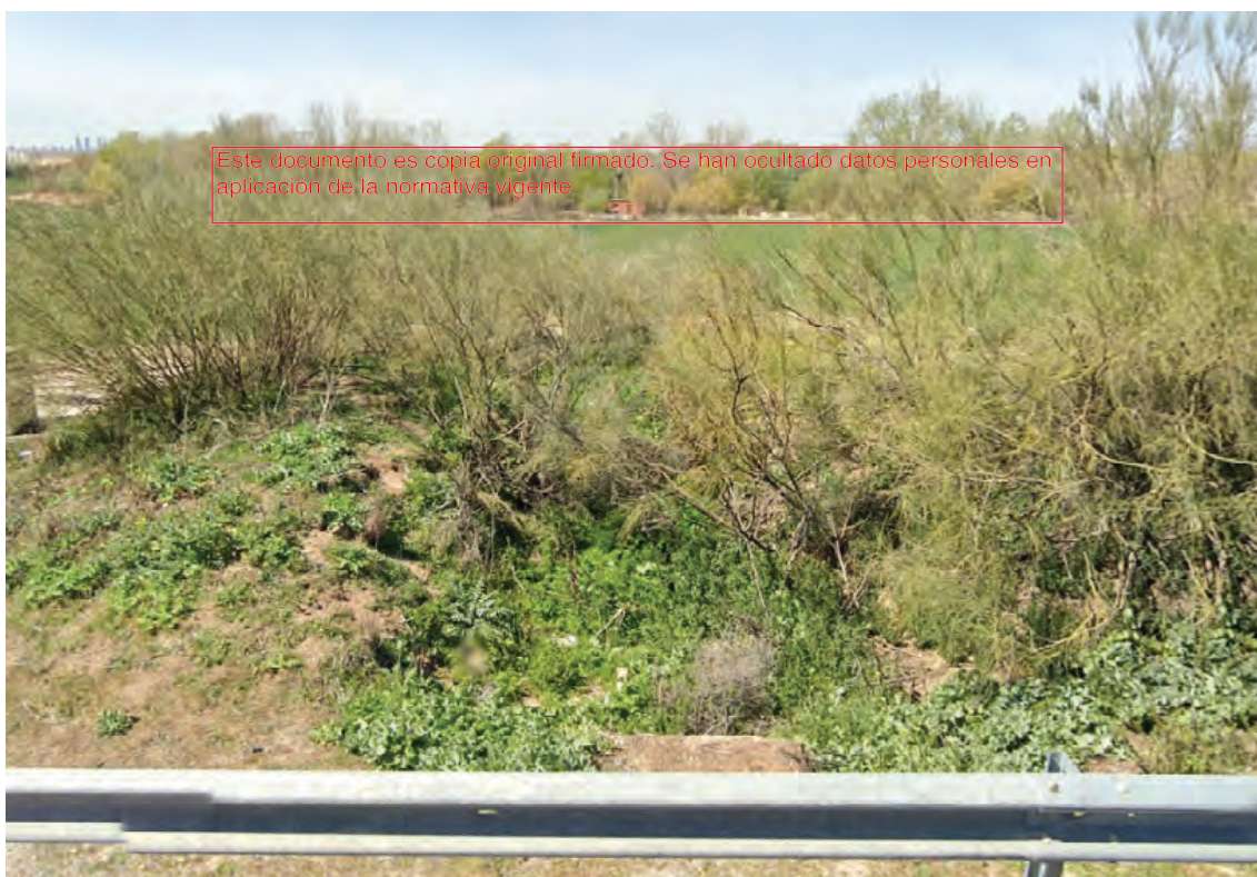
Figura 148. Encauzamiento del barranco de la Viña. Fuente: elaboración propia.
