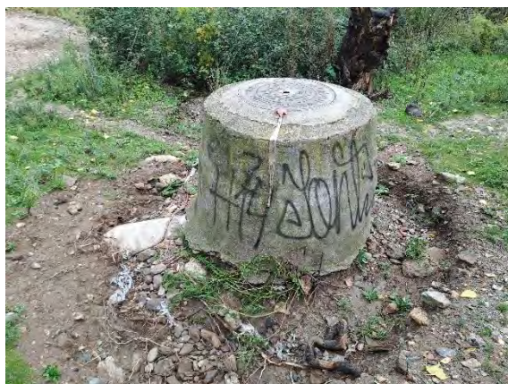
Figura 2.2.1.3.3. – pozo de conexión a colector existente (Fuente: Elaboración propia)
