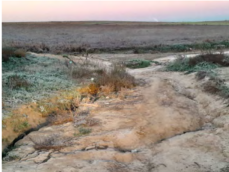
Imagen 8. Cruce Línea subterránea de evacuación 15 kV con arroyo Valdehondillo
