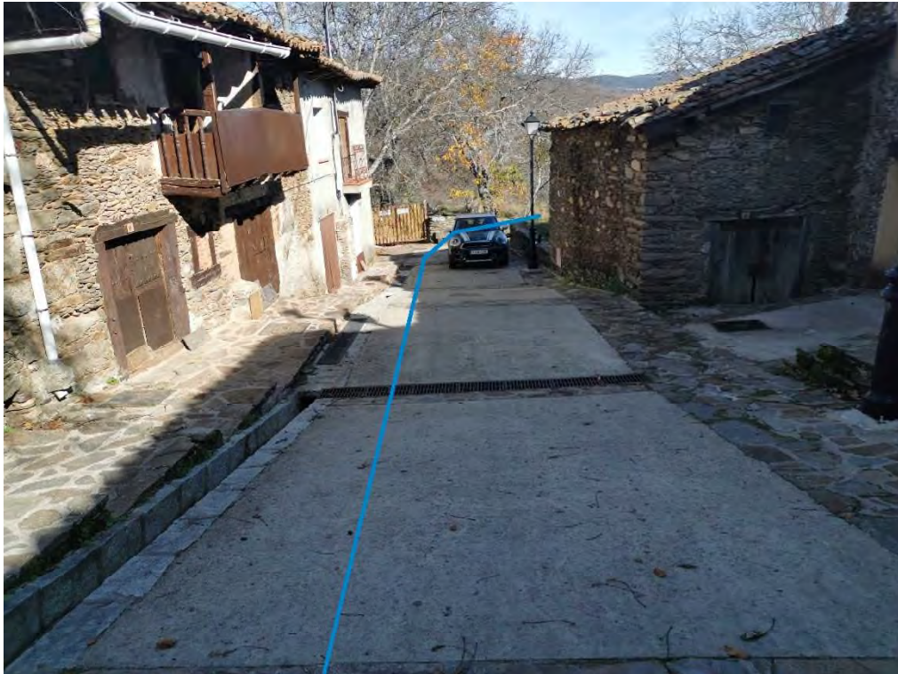
Foto 11. Fin calle Pilón
