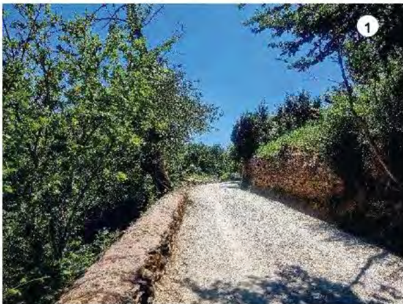
Foto 7. Camino que da acceso a la EDAR de La Hiruela
