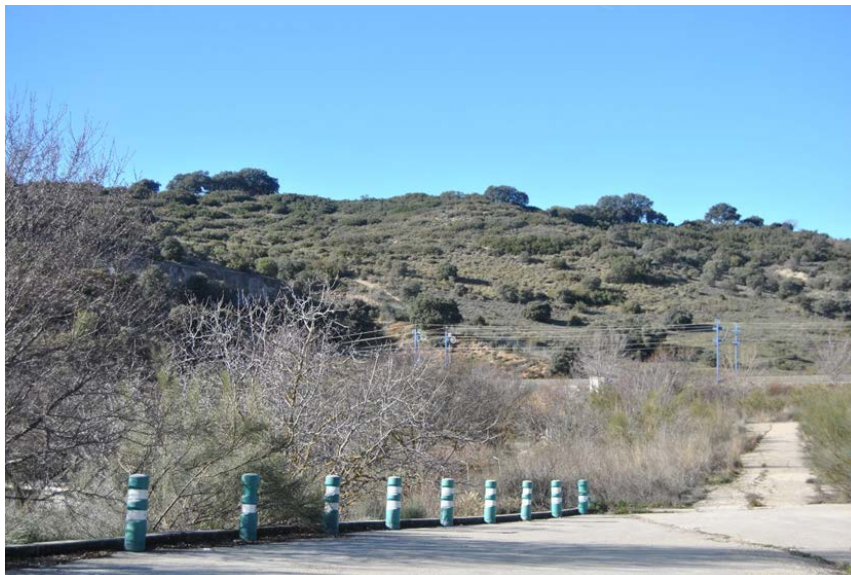
Ilustración 26 Línea de Alta Velocidad
