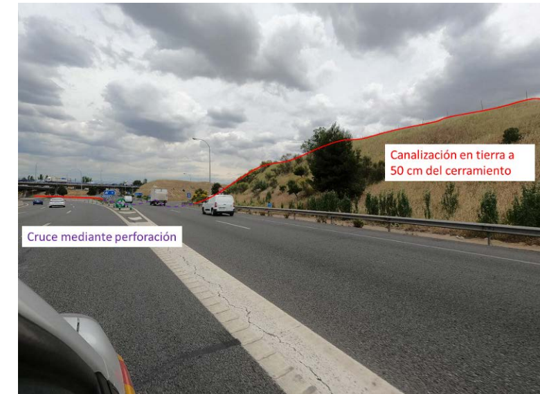
Figura 2: Cruce mediante perforación en PK 10+000
