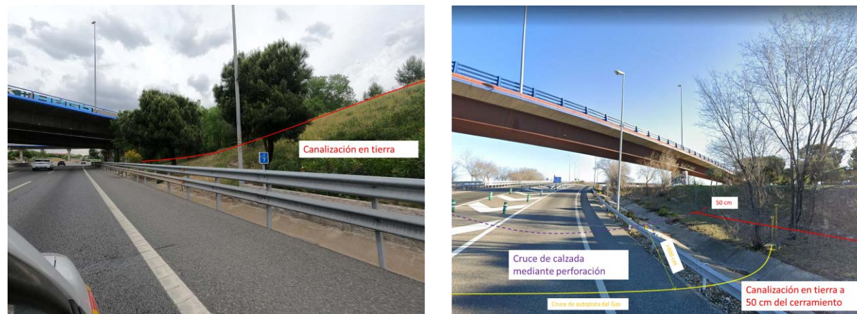
Figura 5: Canalización bajo las estructuras del enlace con la R-3 y perforación PK 14+000
