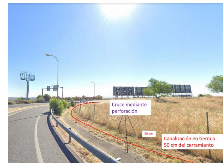
Figura 3: Cruce de la rotonda elevada en el PK 11+000
