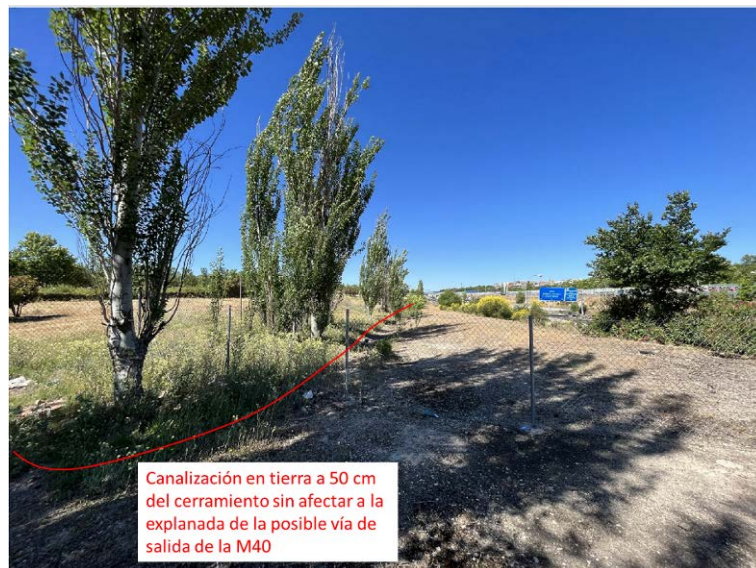
Figura 4: Cruce de la rotonda elevada en el PK 12+500
