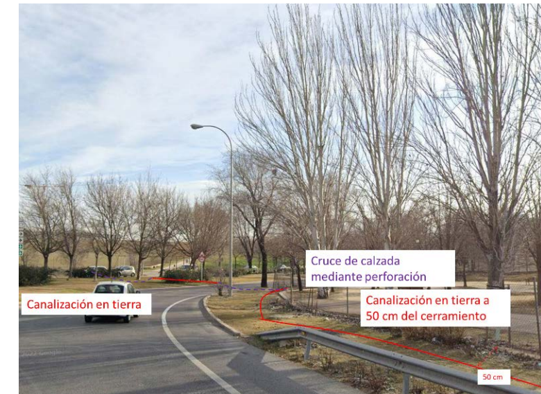
Figura 6: Doble perforación bajo el Camino Viejo de Vicalvaro PK 14+500
