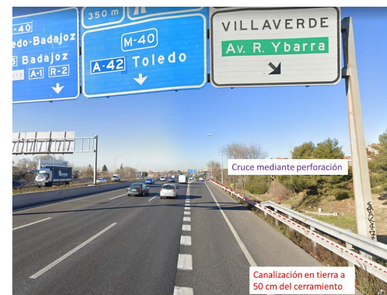
Figura 6: Cruce mediante perforación del vial de salida a Villaverde en PK 24+000
