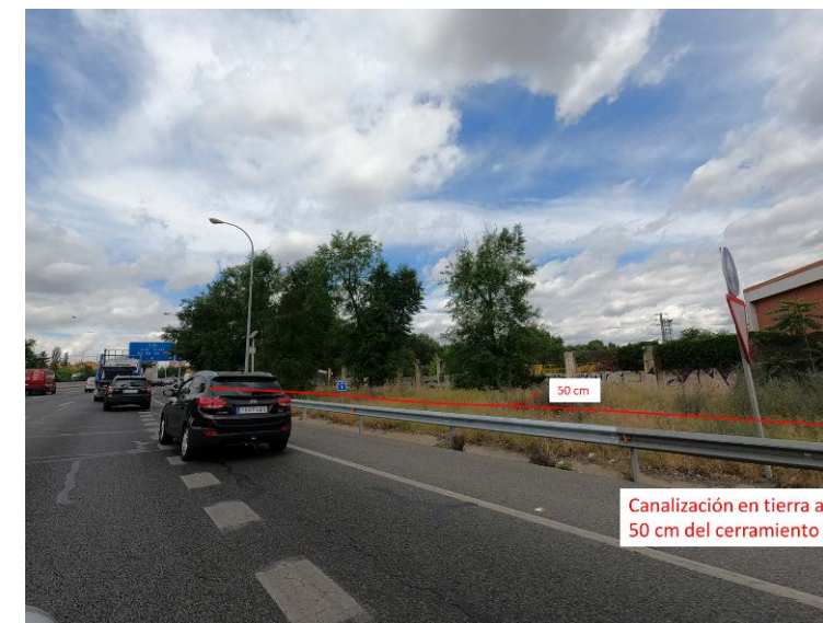
Figura 2: Canalización en la margen derecha a 50 cm del cerramiento, junto a EDAR La China en PK 21+600
