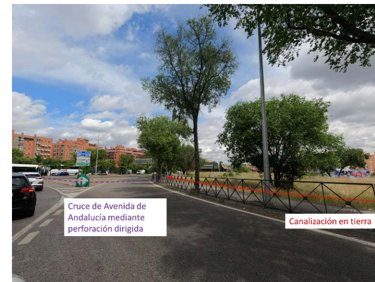
Figura 5: Cruce mediante perforación de la Avenida de Andalucía en PK 22+600
