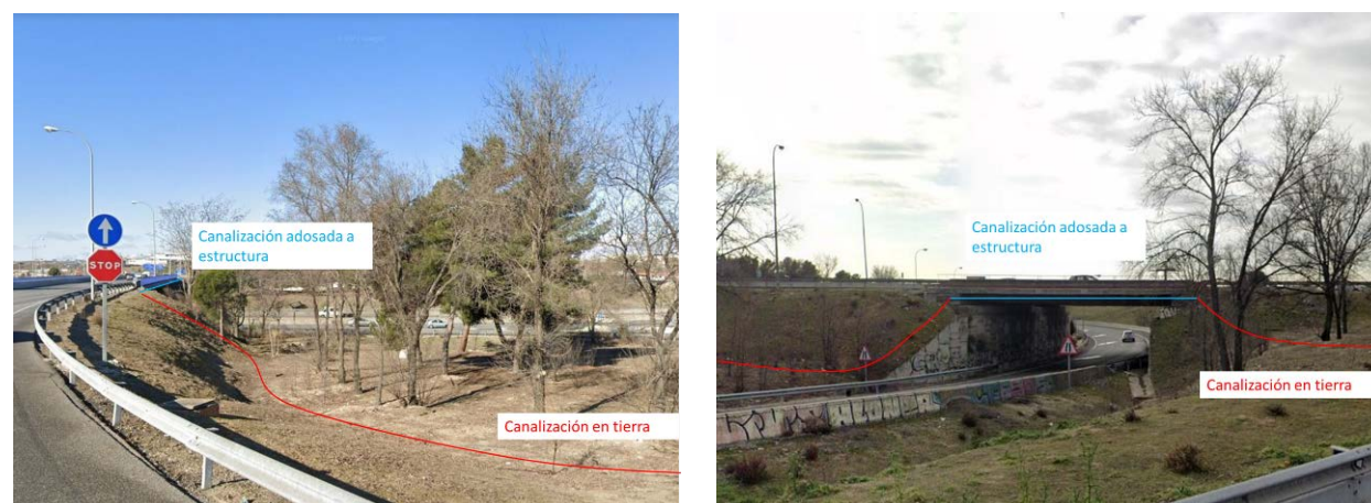
Figura 8: Cruces de estructura en enlace con A42, PK 42+650
