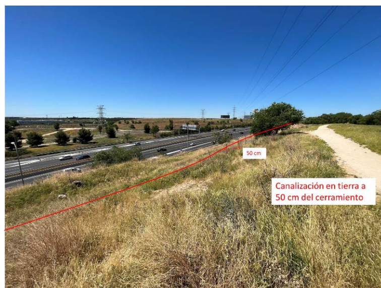
Figura 10: Canalización junto a cerramiento en el entorno del PK 28+250
