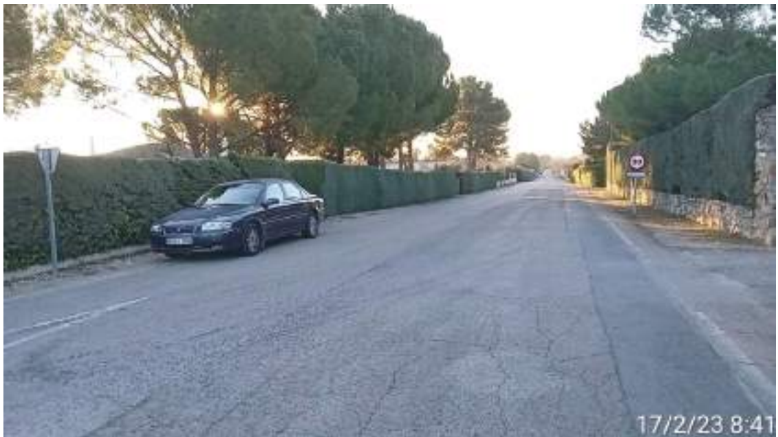
Foto 36.- Vista de la calle 5 desde la Av. Central, a la derecha el depósito
