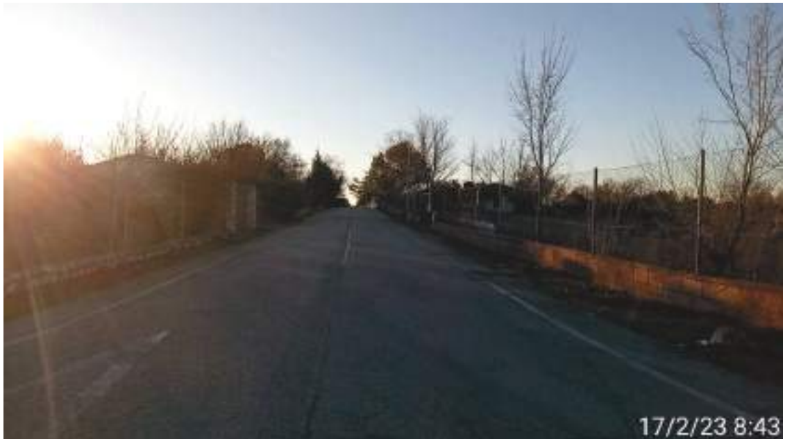
Foto 41.-Vista de calle 1 desde Av. Central.
