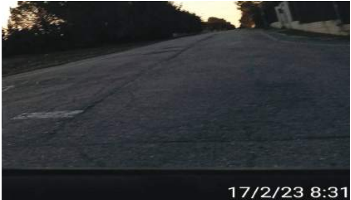
Foto 21.- Vista de calle 2 en intersección con calle 4
