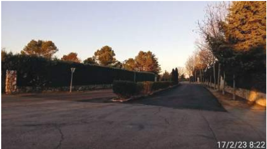
Foto 5.- Vista de la Av. Central a la altura de la rotonda de la calle Cinco y depósito, tramo renovado.
