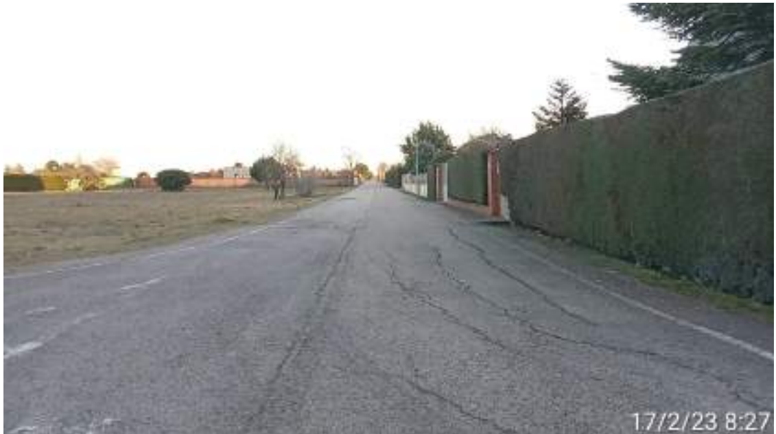
Foto 15.- Vista de la intersección de la calle 2 con la calle 12
