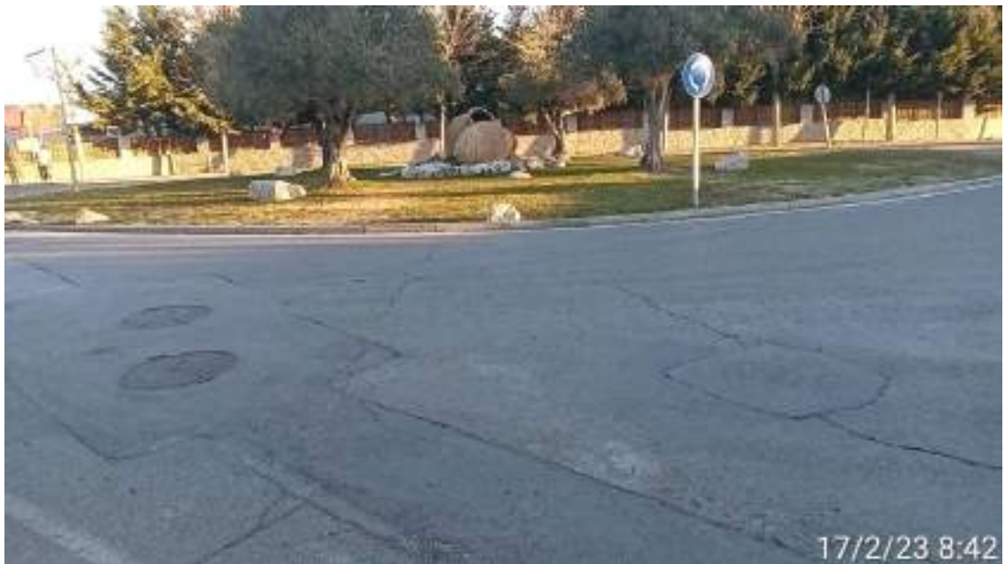
Foto 38.- Vista de rotonda calle 5 con Av. Central, tramo ya renovado
