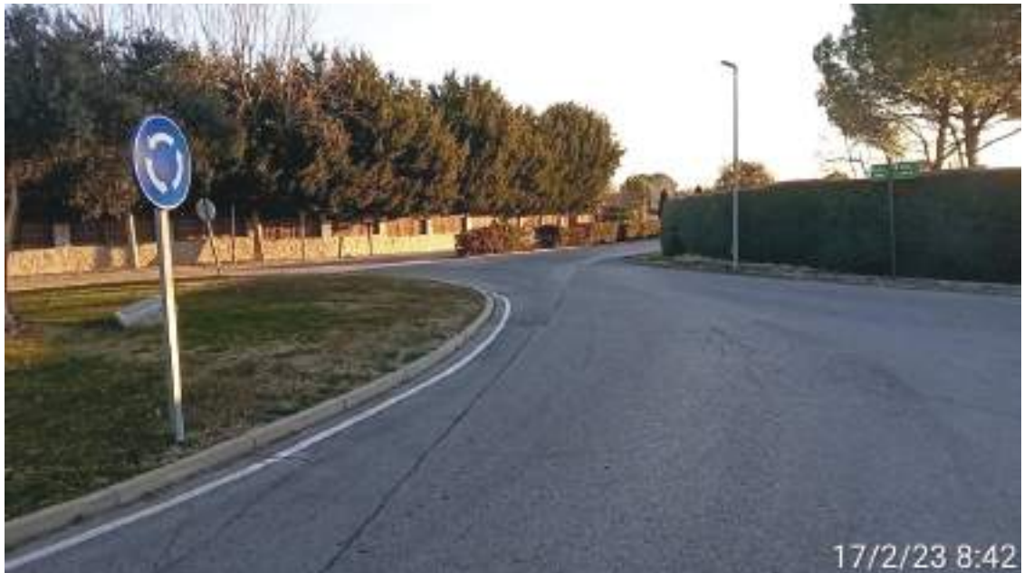
Foto 37.- Vista de rotonda calle 5 con Av. Central, tramo ya renovado
