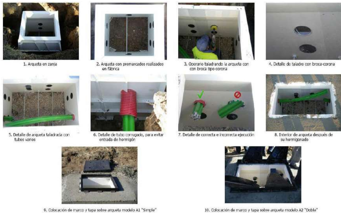
Fig. 8 Imágenes de arquetas prefabricadas en fibra o composite colocadas en obra
