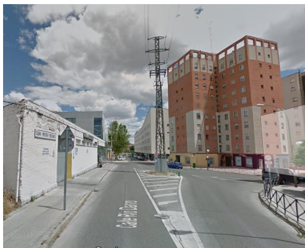
Apoyo en Avda. Olímpica
