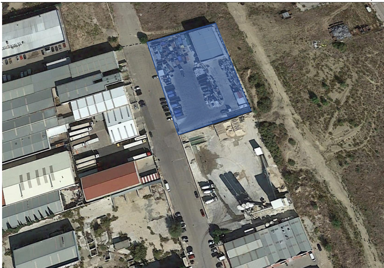
Figura 2: Localización de la instalación localizada en el polígono industrial Miralrio de Velilla de San Antonio. Fte: Google Earth
