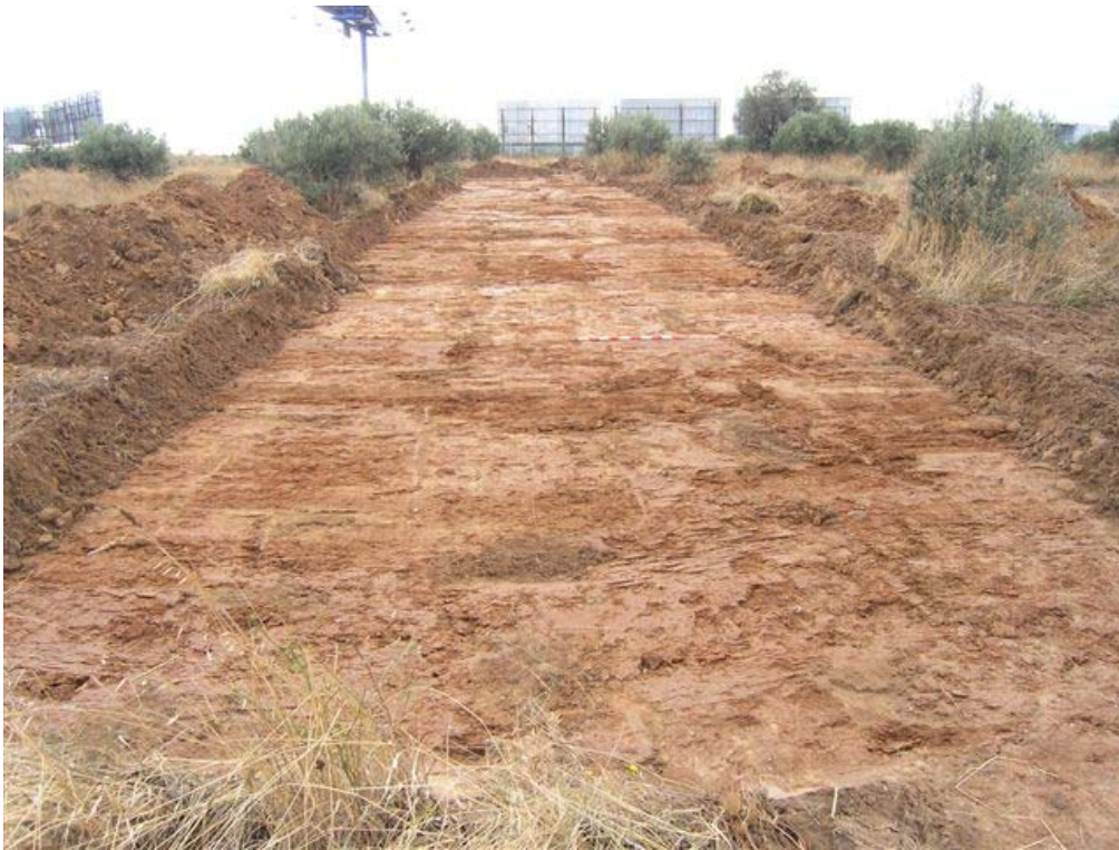
Fotografía 38. Calle 12 tras la apertura, al fondo la A-10.
