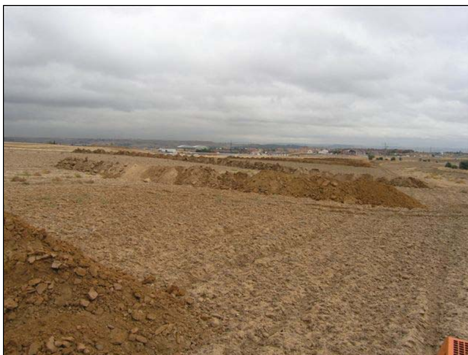
Fotografía 6. Vista parcial del Olivar de Hinojosa tras el desbroce de las calles.
