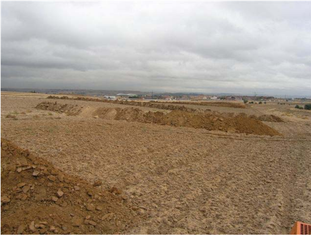
Fotografía 28. Detalle de esa misma zona al término de los trabajos.
