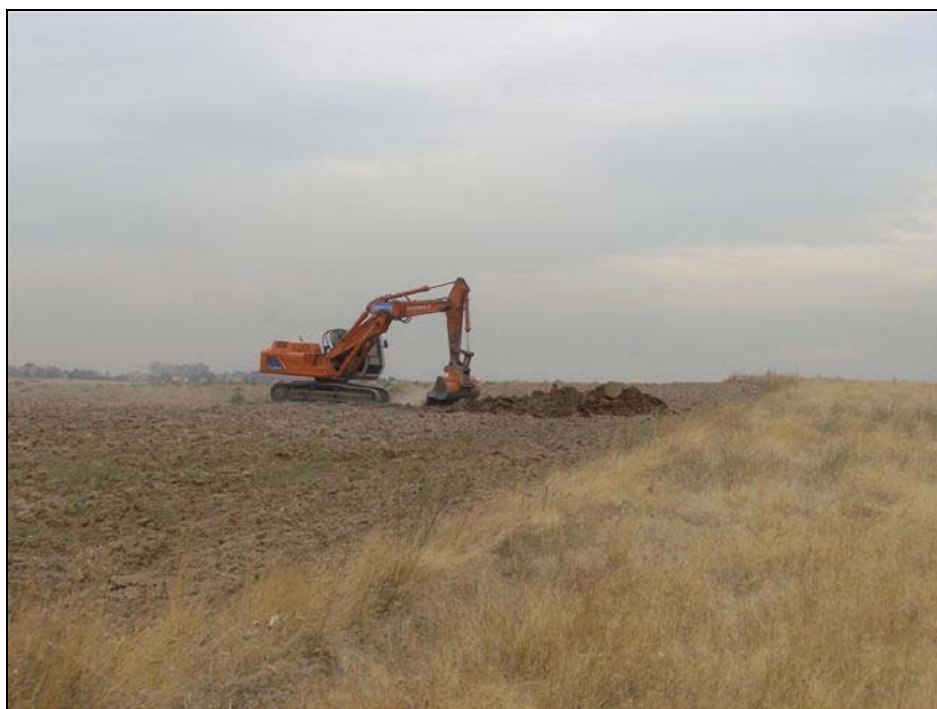
Fotografía 3. Trabajos en el Olivar de Hinojosa durante la segunda fase.
