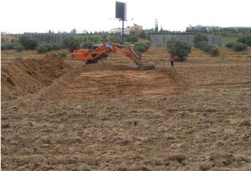
Fotografía 32. Trabajos de desbroce en la apertura de la calle 3.
