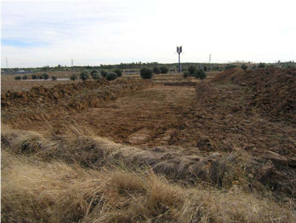
Fotografía 30. Imagen general de la calle 1 tras el desbroce.
