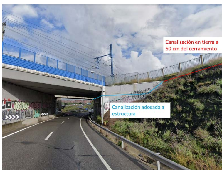
Figura 9: Canalización bajo el ferrocarril en PK 21+000
