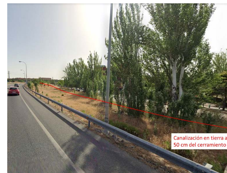
Figura 3: Canalización junto a cerramiento en PK 16+100
