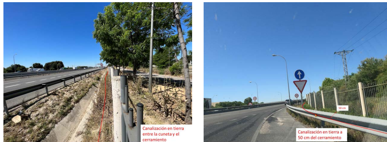
Figura 8: Canalización junto a los cerramientos del parque Garrigues Walker y CIFP Profesor Raúl Vázquez en PK 19+500
