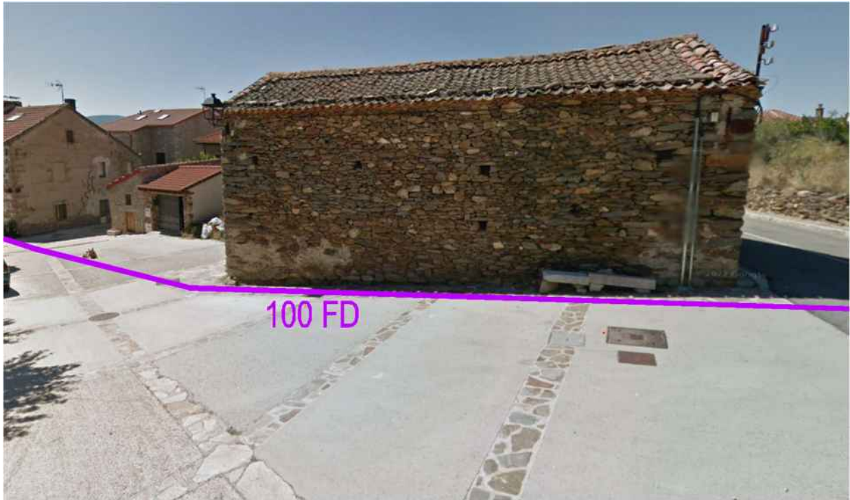
Fotografía 1. Tramo de conducción que discurre paralela a la vía pecuaria Colada del Puente de Madarcos (por el Pueblo) a Horcajo.
