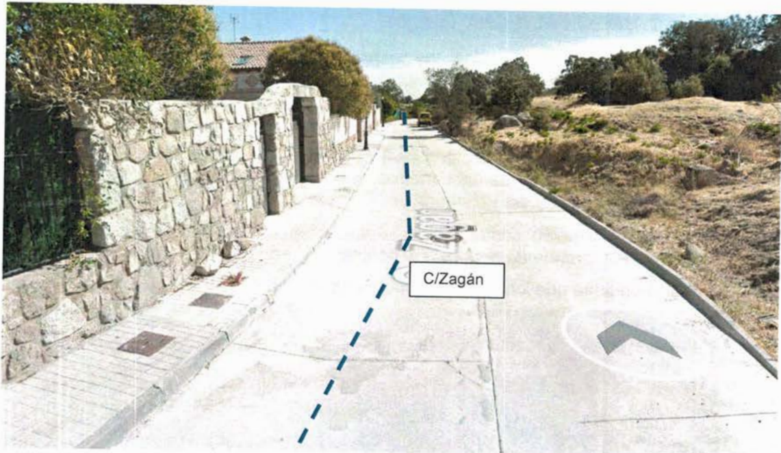
Imagen N.º 4: Calle Zagán.
