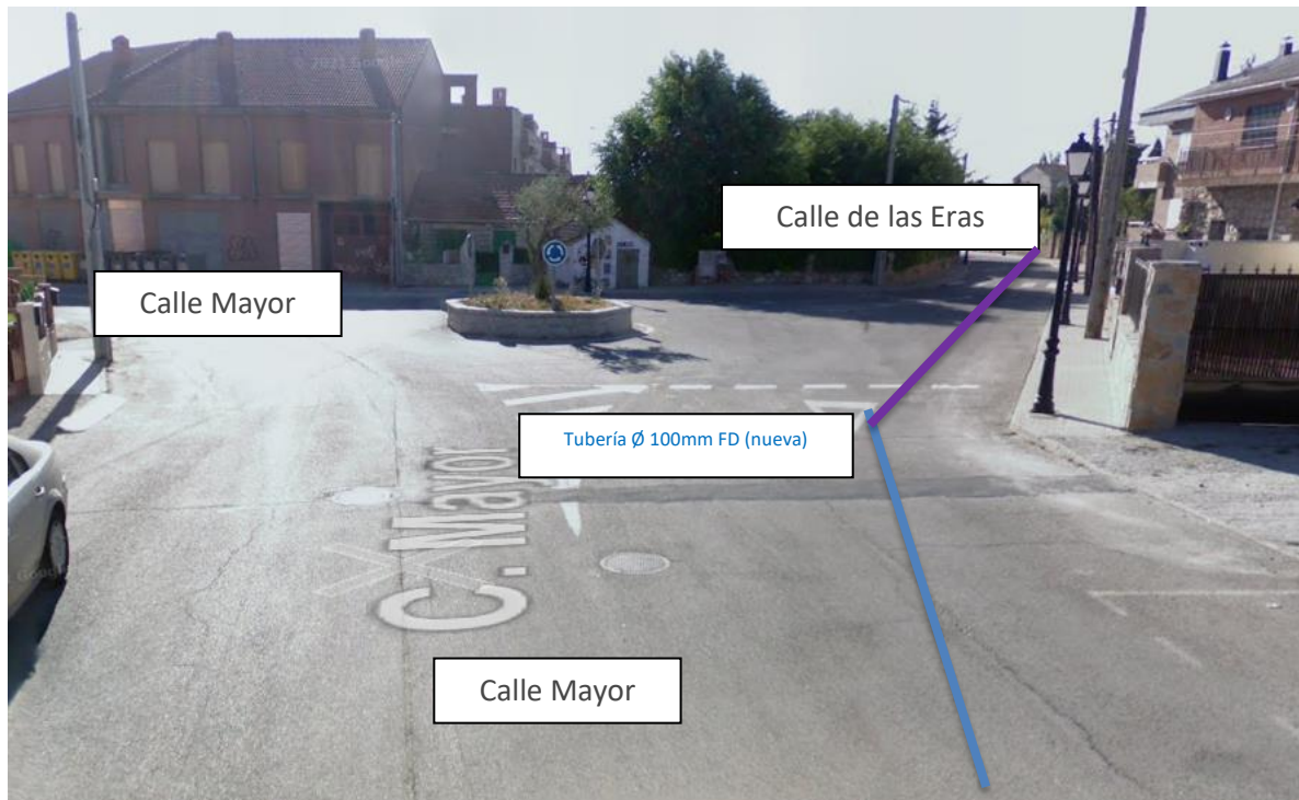
Fotografía 3. Tramo de conexión entre la Calle Mayor y Calle de las Eras.
