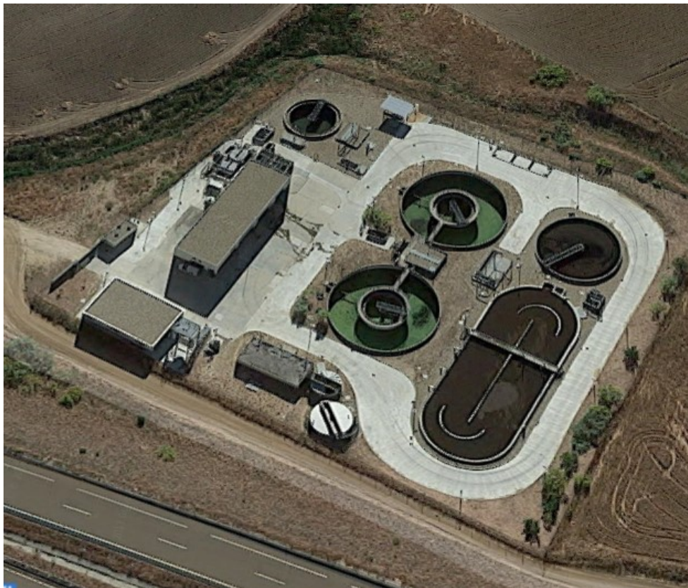
Figura 13.2. Estación Depuradora de Aguas Residuales Fuente: Google Maps. Fecha de la imagen Sept. 2011
