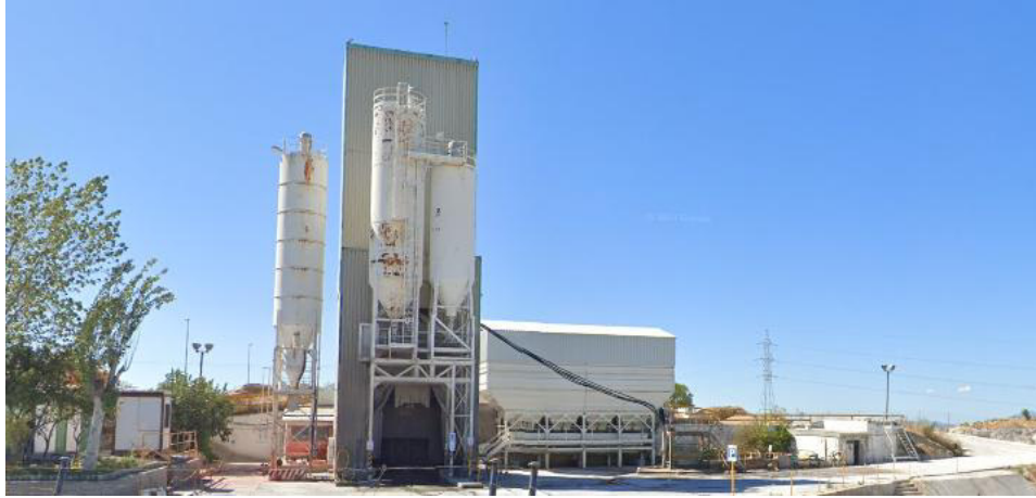
Figura 45. Planta de hormigón.
