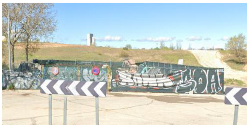
Figura 51. Zona de acopio de materiales de obra en el ámbito de estudio.
