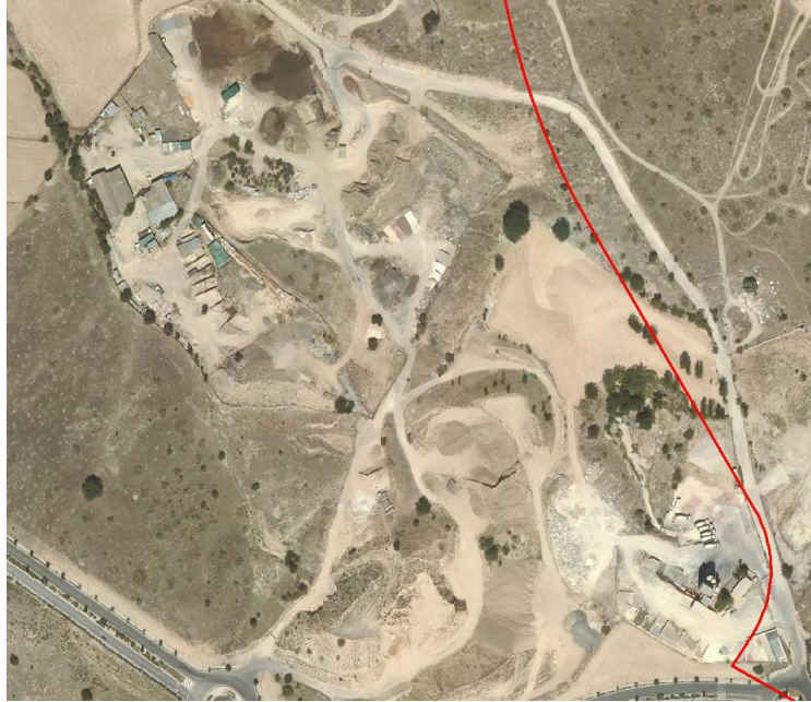
Figura 32. Detalle de la reducción de la actividad extractiva en el exterior del ámbito (Sur) y el acopio de tierra vegetal (Norte) sobre ortofotografía histórica del PNOA. Fuente de la cartografía base: CNIG.
