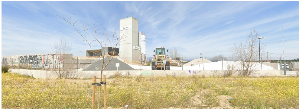
Figura 46. Planta de hormigón.
