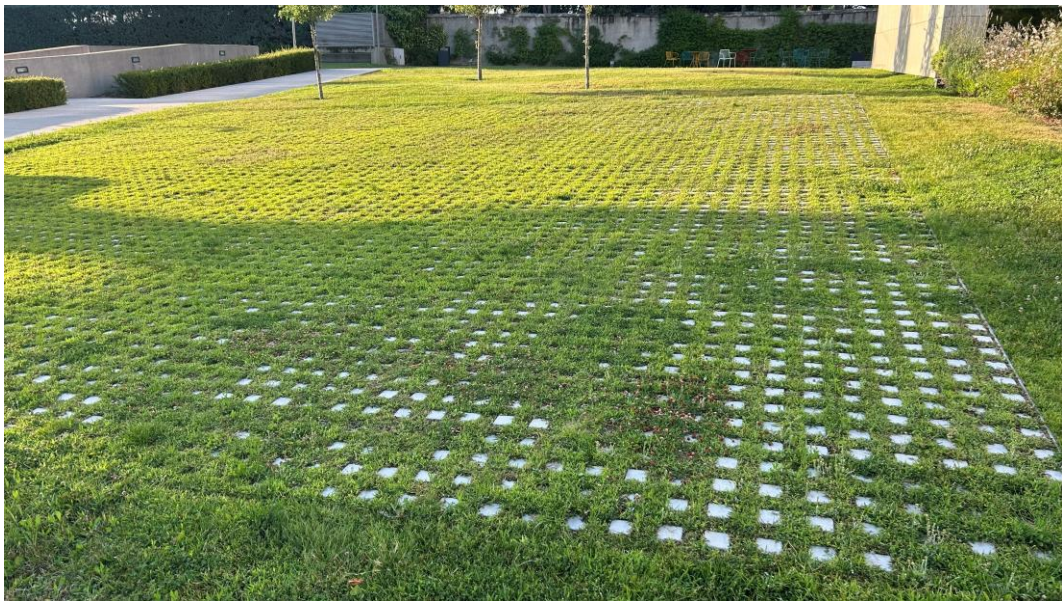
Figura 21. Zona de pavicésped en el ámbito
