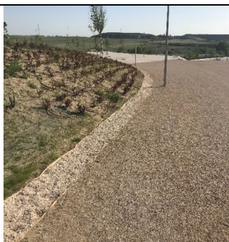
Zanja de infiltración en La Atalayuela, en Madrid.
