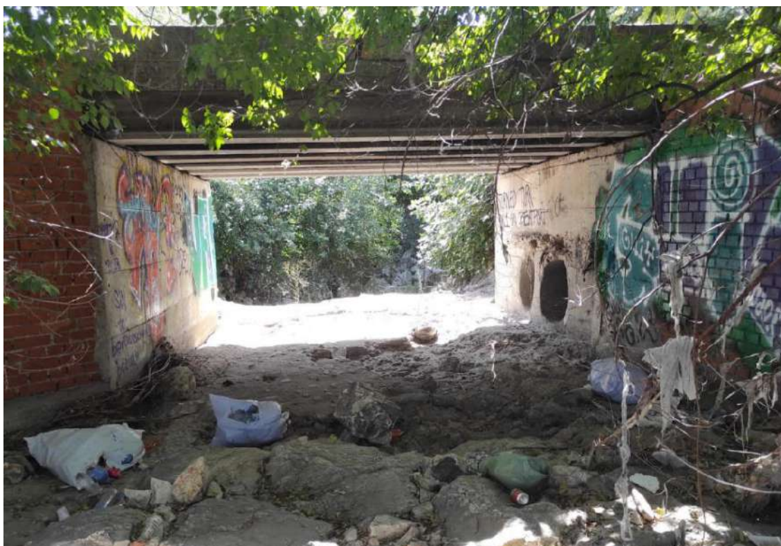
5- DRENAJE01. Drenaje transversal. Cauce
