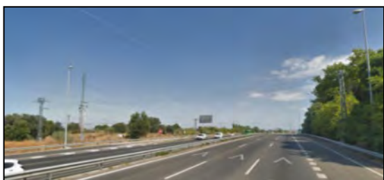
Imagen 6. Línea eléctrica que cruza la M-607 y llega hasta el transformador eléctrico de la finca. (Fuente de la imagen, Google Street View)
