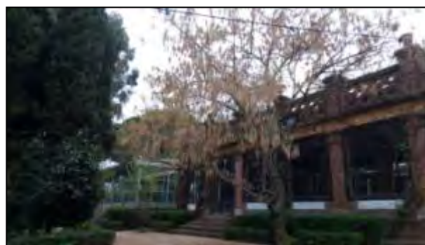
Imagen 70. Fachada trasera del edificio principal desde el jardín trasero.
