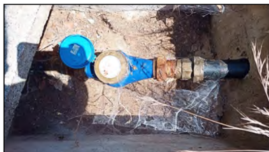
Imagen 25. Contador en la salida de la extracción
