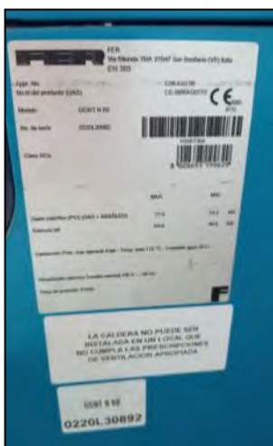
Imagen 40. Chapa con las características técnicas de la calderas
