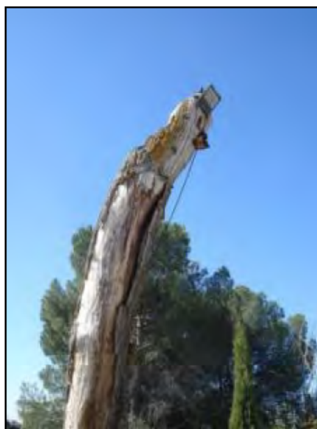
Imagen 86. Punto de luz elevado sobre un árbol seco. Proyector de leds,
