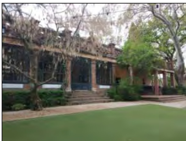
Imagen 69. Fachada trasera del edificio principal desde el jardín trasero.
