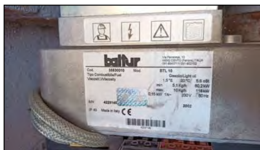
Imagen 41. Chapa con las características técnicas del quemador
