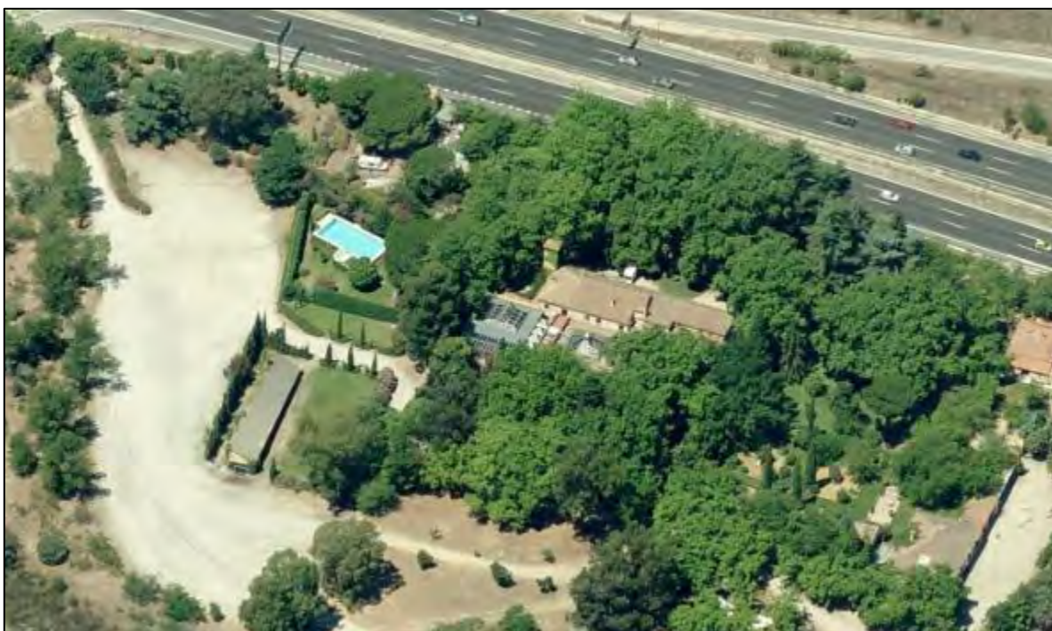
Imagen 45. Vista aérea oblicua desde el este, en el que se observa toda la zona en la que se desarrolla la actividad: acceso a la finca (arriba a la izquierda), aparcamiento (a la izquierda), y edificio principal (en el centro).
