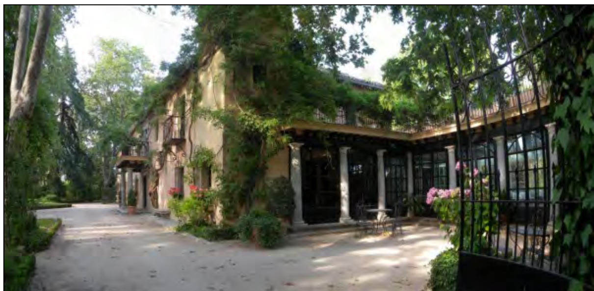
Imagen 56. Entrada al jardín principal al edificio de celebración de actos. Se aprecia a la izquierda la fachada principal, y a la derecha un pequeño patio porticado, unido a la fachada principal por la pequeña torre del edificio.
