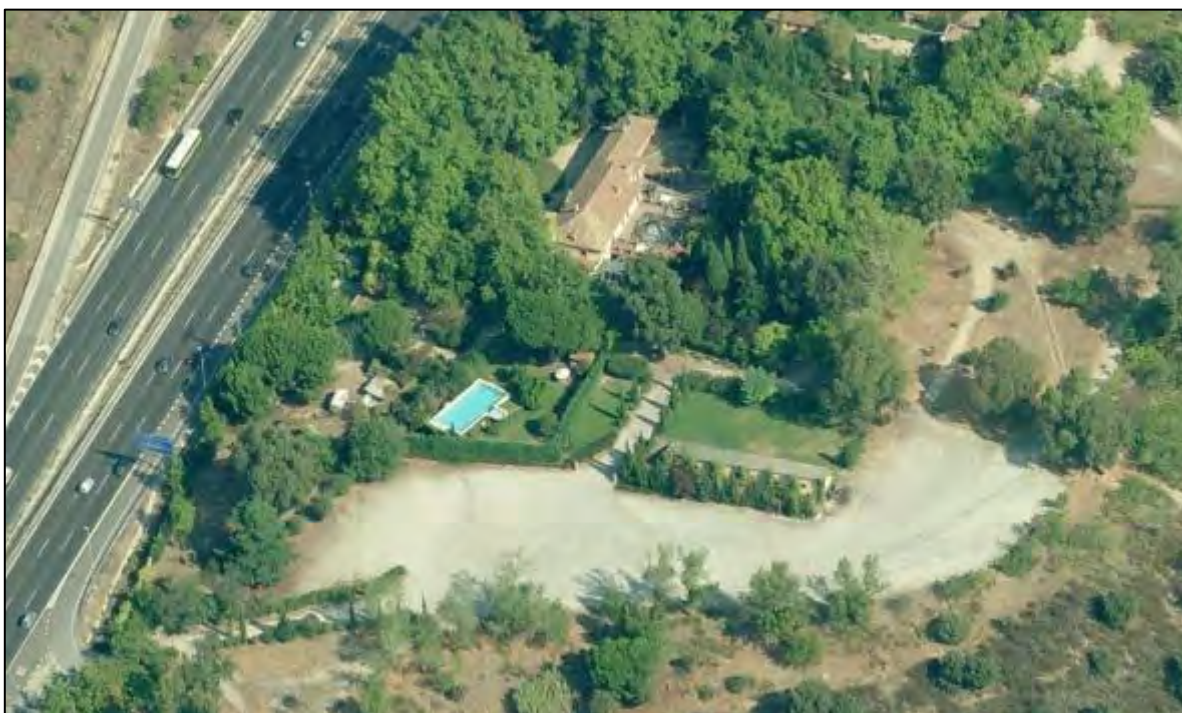
Imagen 46. Vista aérea oblicua de la finca desde el sur. La piscina y el resto de las edificaciones no forman parte de la zona dedicada a la actividad.
