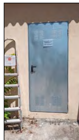
Imagen 37. Acceso al cuarto del depósito en el Cuarto técnico 2.
