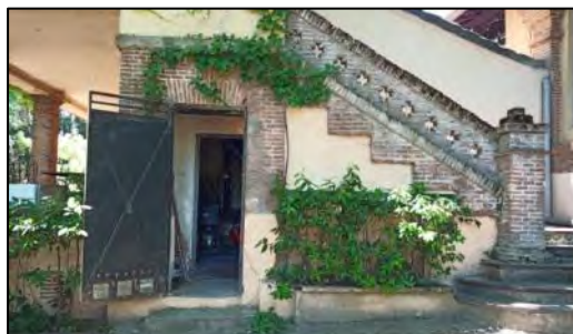
Imagen 19. Exterior del cuarto técnico del edificio principal.
