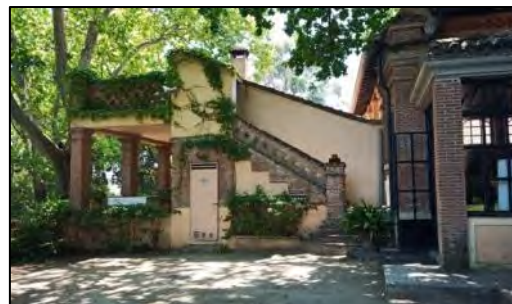
Imagen 18. Exterior del cuarto técnico del edificio principal.
