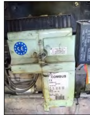
Imagen 33. Chapa con las características técnicas de uno de los quemadores
