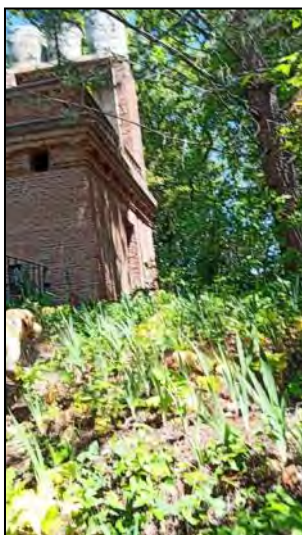
Imagen 26. Construcción del "Cuarto técnico 3"
