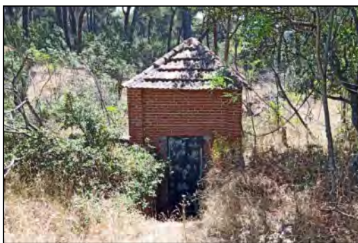
Imagen 13. Acometida de agua potable.
