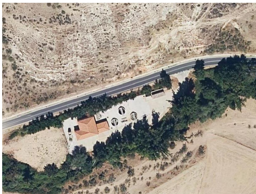
Figura 114. EDAR de El Espartal
