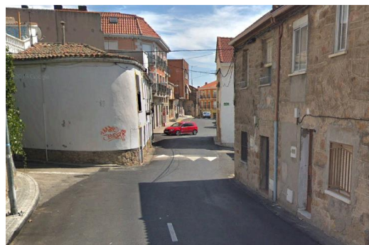
Figura 128. Travesía de El Vellón (M-122) – Estrechamiento.
