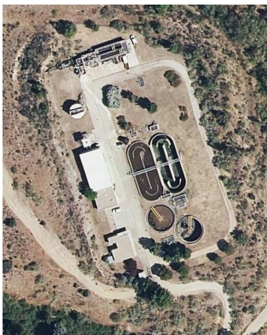
Figura 113. EDAR de El Vellón.
