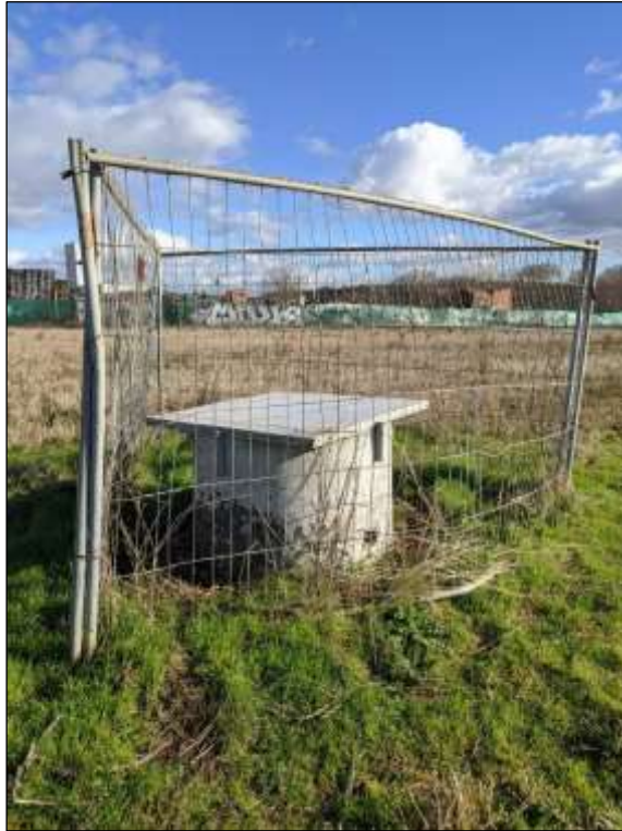
Fotografía 4. Pozo de agua situado en el interior del Sector.
