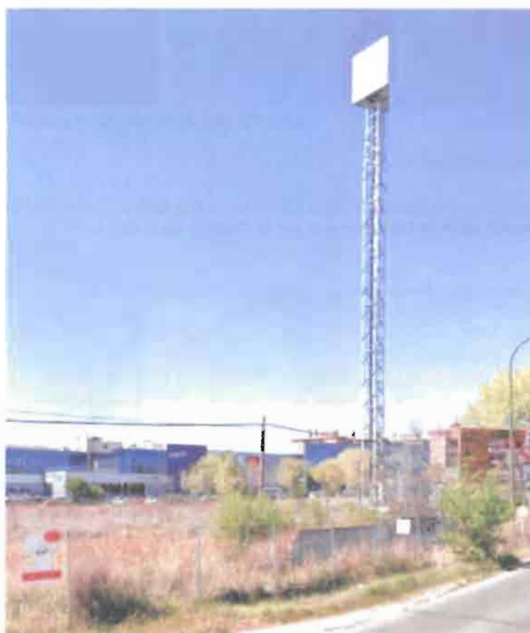
Figura 17: Antena de telefonía situada junto al ámbito
