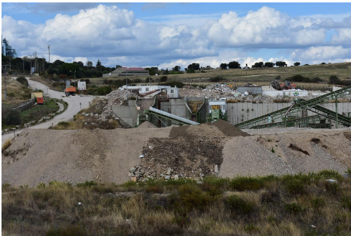
Figura 50. Planta de RCDs y otros elementos y áreas distorsionantes del paisaje. Fuente: elaboración propia.
