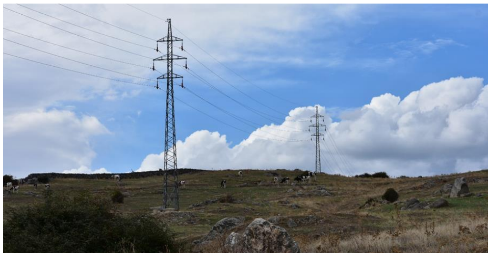
Figura 4. Línea eléctrica de media tensión.
