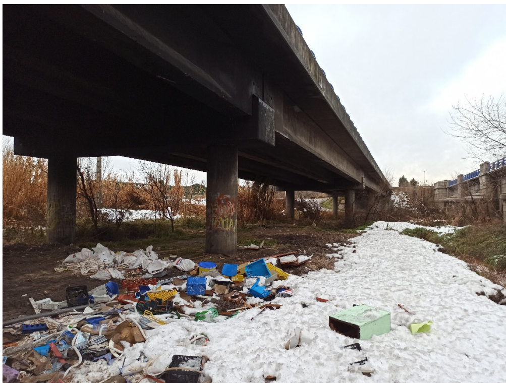
A pesar de incluirse en suelo protegido la realidad del espacio muestra presencia de numeros vertidos y residuos abandonados
