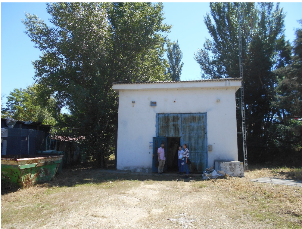
Aspecto de la EBAR actual. En el extremo izquierdo se observa el vallado que delimita el asentamiento humano cercano
