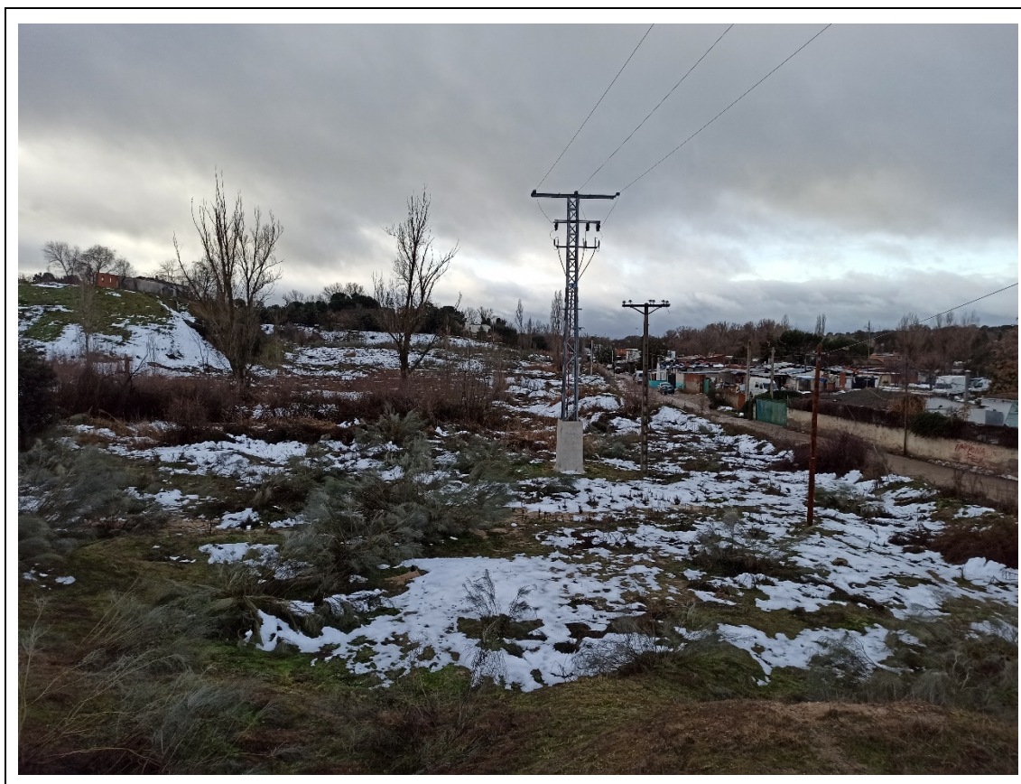
Fotografía 3 Entorno de la zona Norte de la futura EBAR, zona de cruce de la nueva acometida eléctrica y el colector de entrada. Se observan las infraestructuras existentes, el asentamiento cercano y la irregularidad del terreno.
