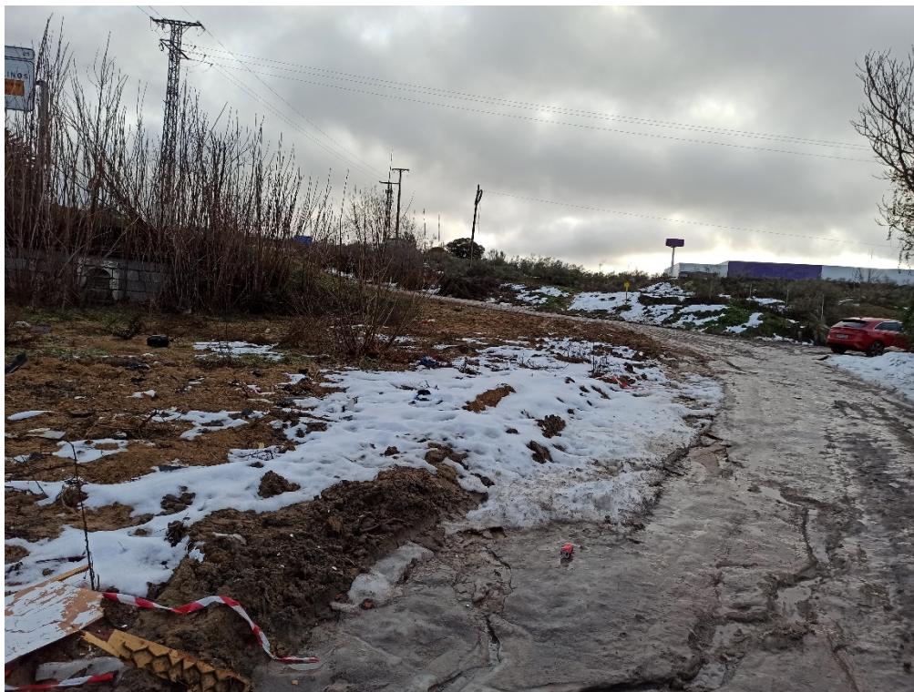
Acceso actual que procede directamente desde el carril de desaceleración de la autovía A-5, que supone un acceso no normativo y muy peligroso desde una vía rápida y con elevado tráfico
