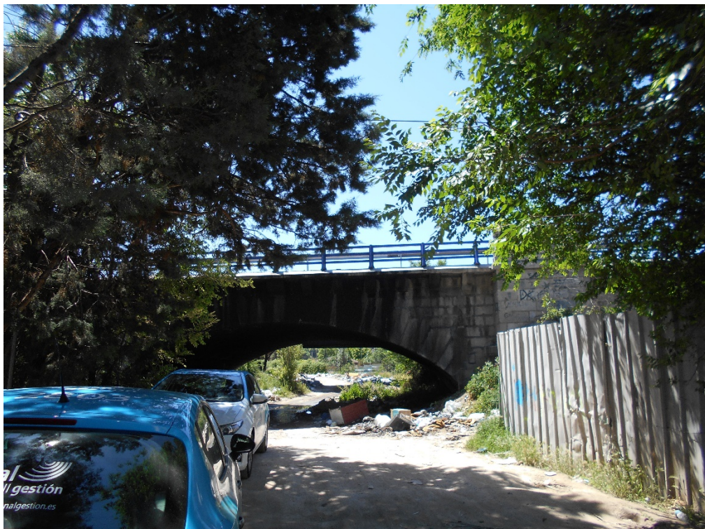
Continuación de la calle Ribera de San Pedro, por debajo del puente de la A-5. Se observan numerosos vertidos incontrolados, dada la marginalidad del entorno.
