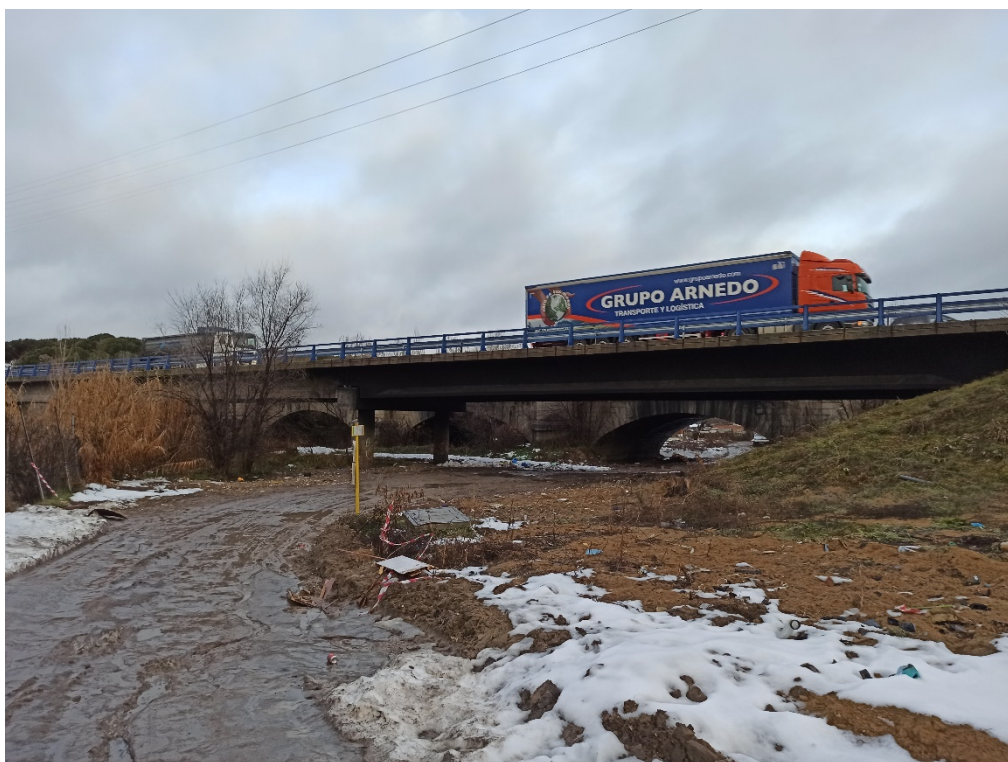
Calle Ribera de San Pedro al Sur del puente de la autovía A-5
