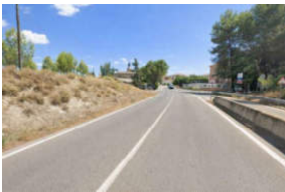
M-217 (Avenida de la Constitución en la zona de la Modificación.
