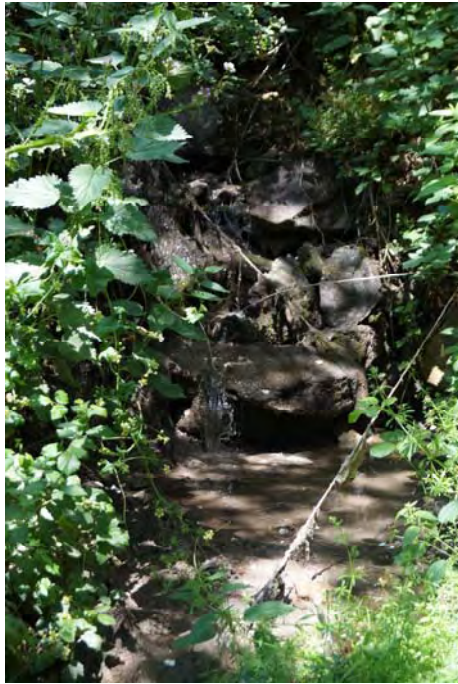
Figura 3.1.1.2.- Punto actual de vertido (Fuente: Elaboración propia)
