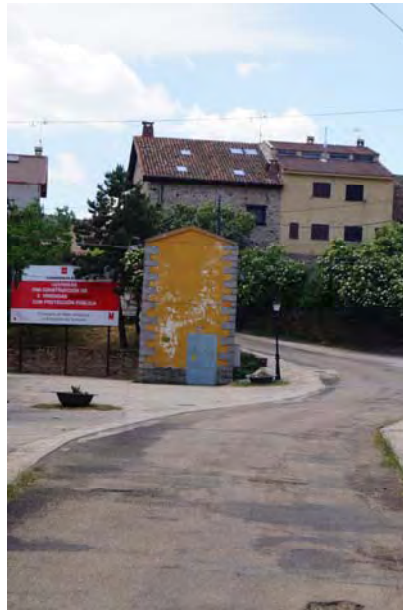
Figura 3.1.2.2.- Inicio colector. Carretera Robregordo (Fuente: Elaboración propia)
