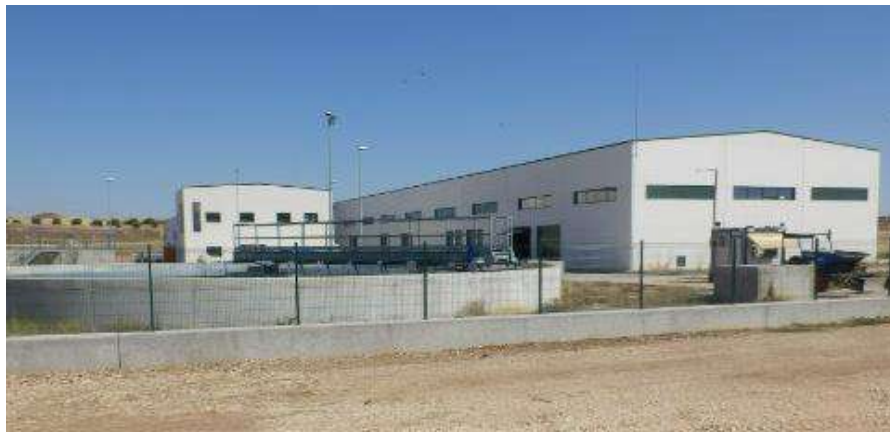
Ilustración 2. Vista exterior de la EDAR de Torres de la Alameda
