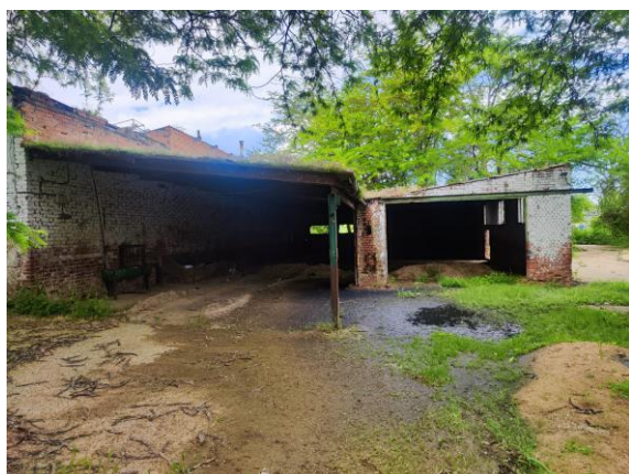
Edificaciones agropecuarias abandonadas.
