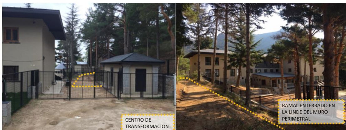
Figura 6: Torre de transformación obsoleta a sustituir por torre que cumpla con la normativa, indicada en el proyecto de alta tensión
