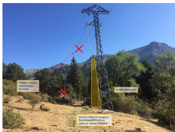
Figura 6: Torre de transformación obsoleta a sustituir por torre que cumpla con la normativa, indicada en el proyecto de alta tensión
