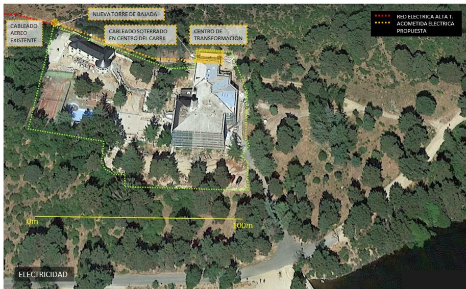
Figura 5: Centro de Transformación y Generación auxiliar y camino compactado dónde se enterrará la línea de media tensión y se dará paso a vehículos de servicio y mantenimiento de la torre de alta tensión ubicado al final.
