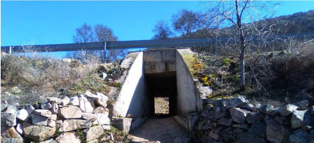
Figura 3.2.3.6.- Obra de paso transversal bajo AV-P-308.
