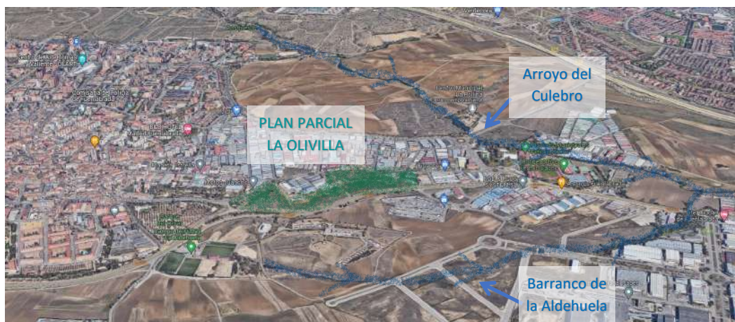
Vista 3D de la parcela del Plan Parcial y del entorno con indicación de los dos cauces más cercanos
