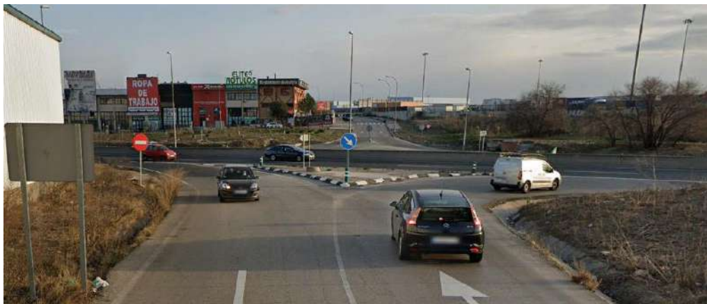
Fotografía 10 Acceso 2 hacia/desde la M-506
