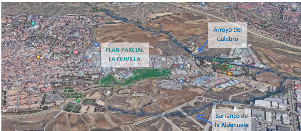
Vista 3D de la parcela del Plan Parcial y del entorno con indicación de los dos cauces más cercanos
