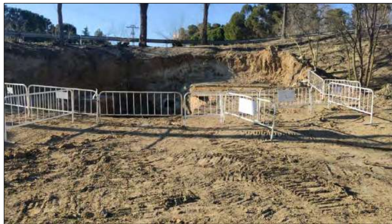
Fotografía 1. Obras colector extremo oeste del ámbito. Fuente elaboración propia.
