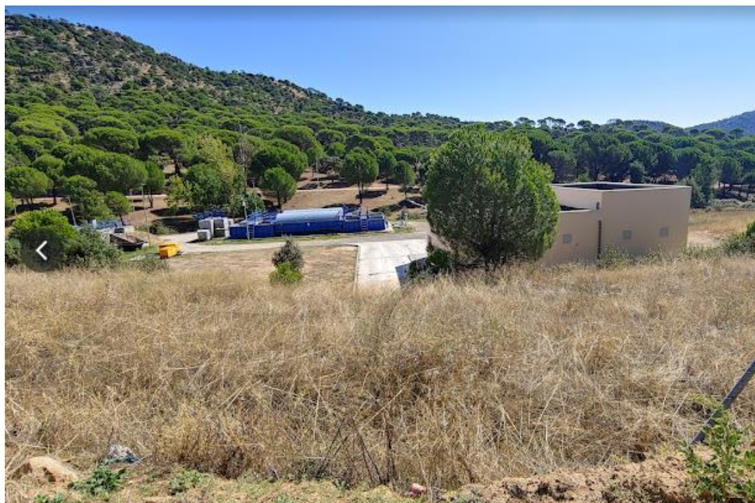
EDAR de Valdemaqueda, en el municipio de Valdemaqueda
