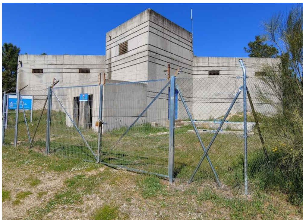
Depósitos de agua que abastecen a Valdemaqueda. Fuente: Elaboración Propia
