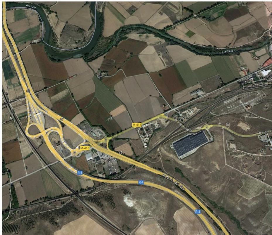
Figura 8: Fotografía aérea de las carreteras que rodean al Plan Parcial Sector X “Entrevías”.
