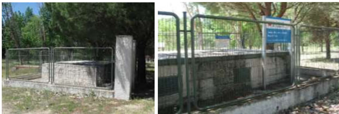
Ilustración 10. Pozo B-1.bis. Fuente: Canal de Isabel II
