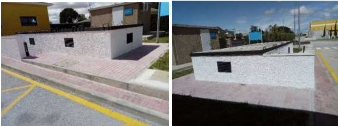
Ilustración 14. Pozo B-4.bis. Fuente: Canal de Isabel II
