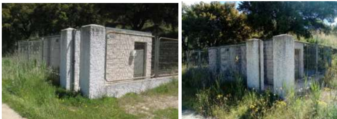
Ilustración 12. Pozo B-3.bis. Fuente: Canal de Isabel II
